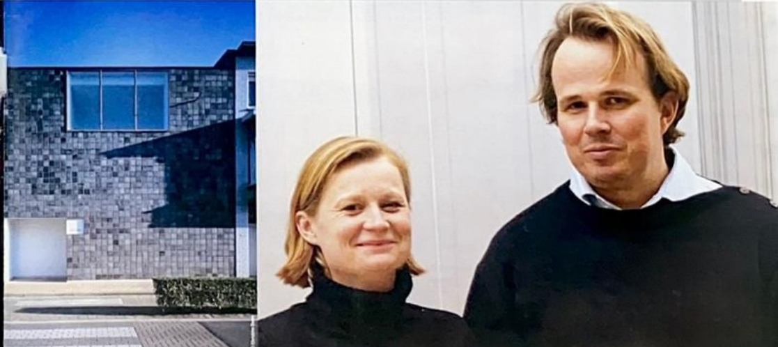
La façade du Musée Luc Peire à Knokke a été recouverte de dalles de Boom de 20 X 20 cm.
